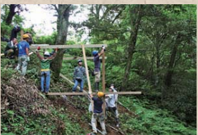
急斜面にデッキを作る。まずは土台から
