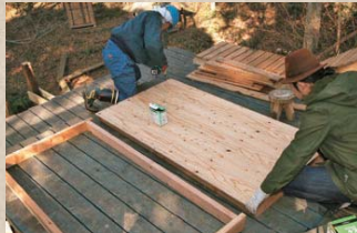
2×4材でパネルの骨組みを組み、合板を張る。これを8枚
