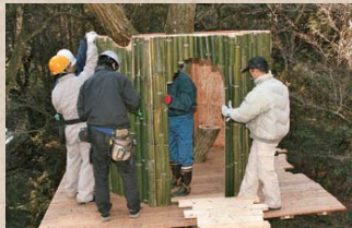
竹を張った8枚のパネルを上段デッキの上で組んでいく。入口は大きく開口させている
