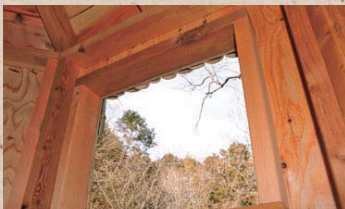
内側から天井を見上げる。屋根材の下の垂木が放射状に取り付けられているのがわかる
