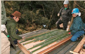
合板の上に半割あるいは3分割の竹を張っていく。下穴をあけてからビスで打ち留めていく
