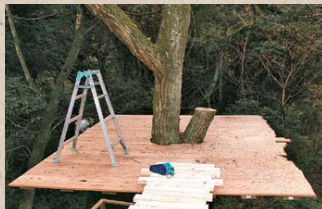
右側に飛び出していた太い枝を思い切ってカット。これで壁パネルを組みやすくなった
