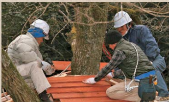
垂木を木の幹から放射線状に付けていく。幹には垂木が載る八角形の輪が見える
