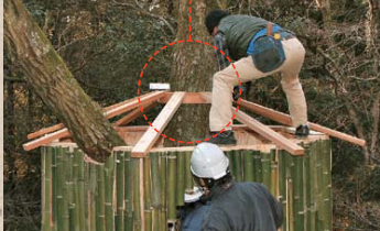
垂木を木の幹から放射線状に付けていく。幹には垂木が載る八角形の輪が見える
