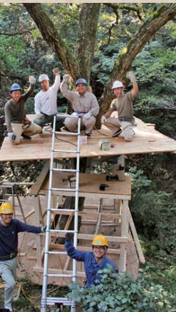
取り付けられたアンゲルの上に根太(3寸角のスギ材)を取り付ける。アンゲルには根太を取り付けるためのボルト穴があけられている
