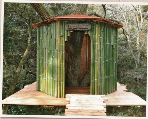
近くの山から伐採した青竹を外壁に張ったユニークなツリーハウス。チョット見、モンゴルのバオ?
