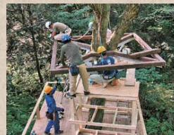
取り付けられたアンゲルの上に根太(3寸角のスギ材)を取り付ける。アンゲルには根太を取り付けるためのボルト穴があけられている
