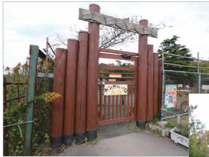
ボランティア塗装に使用しているのは、高耐久性の(水性)造膜型塗料「キシラデコールコンゾラン」。カンガルーの飼育ゾーンでは、木製の門柱を塗り替えた
