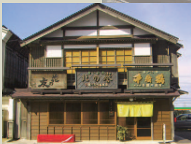
街路事業に併せて、外部の景観改修がされた大正12年建築の建物。木部には保護塗料としてキシラデコールを用いている。
