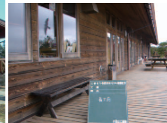
塗り替え工事終了後の外観(上)。正面エントランス側は西に面していて、日差しと風当たりの影響で劣化も著しかった。写真右は、塗り替え工事前の建物南面
