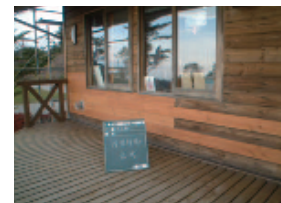
外壁材の張り替えを終えたところ。外壁全体の2割弱を張り替えた
