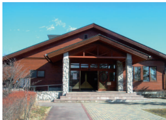
塗り替え工事終了後の外観(上)。正面エントランス側は西に面していて、日差しと風当たりの影響で劣化も著しかった。写真右は、塗り替え工事前の建物南面
