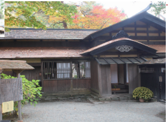
秋田県指定文化財の岩橋家。江戸時代末期に改造された際、茅葺きから木羽葺きに変えられたと伝えられている。下屋根は今秋葺き替えを終えたばかり。
