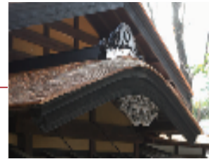
秋田県指定文化財の岩橋家。江戸時代末期に改造された際、茅葺きから木羽葺きに変えられたと伝えられている。下屋根は今秋葺き替えを終えたばかり。
