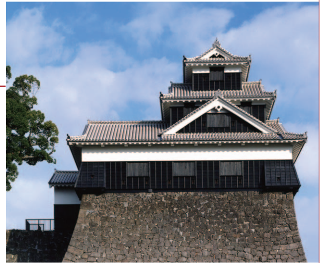
木造三層五階建ての飯田丸五階櫓。2005年2月に復元。高さ15メートルもの石垣の上に建つ（写真提供：熊本城総合事務所）
