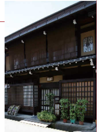
建物の表面でひときわ目立つ褐色の格子とひさしを支える腕木。腕木の先端を白く塗るのも、伝統的建造物群保存地区内の約束事の一つ
