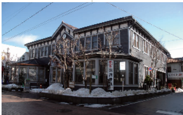
旧軽井沢の中心地に位置する軽井沢観光会館。この場所明治44年に建築された郵便局舎の外観を模して、地元軽井沢町が1995年に新築した。外壁にはキシラデコールの「シルバグレイ」を採用、昨年12月に塗り替えを終えた
