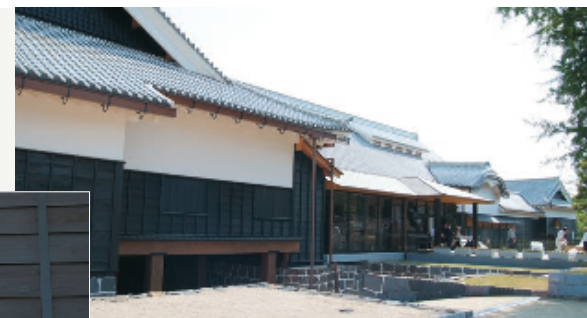
熊本市では3年前に築城400年を迎えた特別史跡の熊本城で、往時の雄姿を復元・整備する事業に取り組む。耐久性を第一に考えて、木材保護塗料にはキシラデコールを用いた。写真は、築城400年祭に合わせて公開された本丸御殿大広間。この建物では、外壁には元の仕上げと同じく黒く見えるように、キシラデコールの「ジェットブラック」を塗布した
