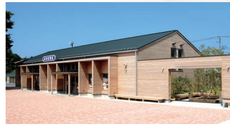
2010年4月に完成した売店棟。2カ所ある入場ゲートの一つ、まきばゲートの近くに位置する。使用している木材はゲート棟やトイレ棟と同じ北欧材。仕上げにはこの建物も、木材保護塗料としてキシラデコールを用いる
