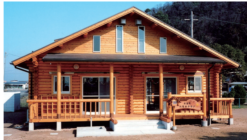
◎公共施設事例「水巻町えびり児童クラブ」/ウッディ工房の「マシンカットログ工法」を用いた福岡県遠賀郡内の小学校児童保育所。公共施設では児童保育所のほか、駅舎や図書室などにも利用されている
