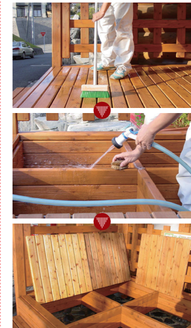
ウッディ工房オリジナル国産スギ製「システムウッドデッキ」にも嶋崎健一社長の考え方は反映されている。板材を一定の間隔を開けて目透しで並べた床パネルは、それを受ける材との間に金具をはさんで3mmほど浮かせ、風通しを確保。日常のメンテナンスとしては、水洗いし、ブラシでホコリや汚れを取り除くことを勧める。時には取り外し可能な床パネルを裏返して用いれば、紫外線による表面の劣化や湿気による裏面の劣化の均一化を図ることができる。さらに床下は、全部収納庫として使える
