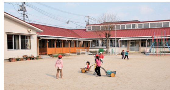
左 左手に見える事務室と、そこから右方向、既存の園舎との間を結ぶ渡り廊下を、2010年度工事で増築した。下 渡り廊下の床には耐久性の高いオーストラリアヒノキを、構造部材や腰壁にはヒノキを用いた。構造部材や腰壁には木材保護塗料として「キシラデコール フォレストージ」を塗布している
