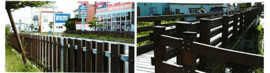
写真左は、能代市内を通る国道7号沿いに設置された木製の乱横断防止柵。木材高度加工研究所が民間企業と共同で、地元のスギ材を活用し開発した。右は、市内を流れる運河に架かる中川原2号橋。主桁にスギ集成材を用いる。当初の仕上げはそれぞれ、「キシラデコールフォレストージュ」と「キシラデコール」
