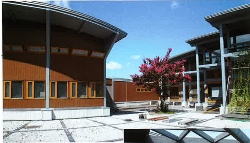
木材高度加工研究所本館南側。シンボルツリーを境に、右は柱・梁や軒天などを、左は外壁や軒天などを、それぞれ「キシラデコールコンゾラン」で塗り替えた
