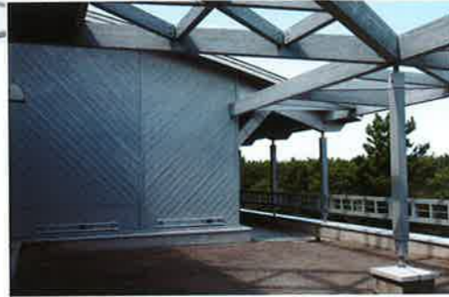
研究所本館の西に続く研究棟北側バルコニー。正面の外壁を同じスギ板で張り替えたうえで、柱や手すり、パーゴラの梁などとともに塗り替えた
