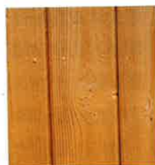
花巻市立成島保育園。昨年10月、木製の外壁と金属製の屋根を塗り替えた。外壁の塗り替えに用いたのは、キシラデコールコンゾランの「ビニー」。写真右上のように、木質感が損なわれないのが、特徴の一つだ
