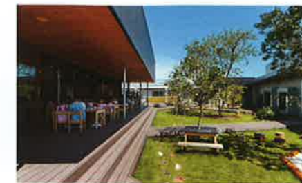
土舎舎利保育園園舎 所在地/茨城県神栖市矢田部7793-16 設計/日比野設計+幼児の城 構造・階数/木造平屋建て 敷地面積/7179.41㎡ 延べ床面積/1464.90㎡ 園児定員/110名 風の強い地域であることから、落ち着いた外遊びの空間を確保する狙いで中庭を設けた。ここを中心に、0~2歳児用保育室、3~5歳児用保育室、ランチルーム、遊戯室が、かざぐるまの羽根のように配置される
