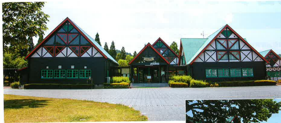
工作室を備えた「クラフト館」。ハーフトンパー様式を採用していたが、改修工事で外壁面の下半分は大壁に改め、外壁面を「キシラデコールコンゾラン」の「ジェットブラック」で仕上げた。写真右下は、研修室や展示室などを備えた「木の館」。黒く見える外壁面は、やはり「キシラデコールコンゾラン」で仕上げた。これらを含めて屋外木部にはすべて、「キシラデコールコンゾラン」を使用する
