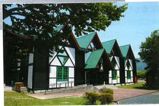
工作室を備えた「クラフト館」。ハーフトンパー様式を採用していたが、改修工事で外壁面の下半分は大壁に改め、外壁面を「キシラデコールコンゾラン」の「ジェットブラック」で仕上げた。写真右下は、研修室や展示室などを備えた「木の館」。黒く見える外壁面は、やはり「キシラデコールコンゾラン」で仕上げた。これらを含めて屋外木部にはすべて、「キシラデコールコンゾラン」を使用する
