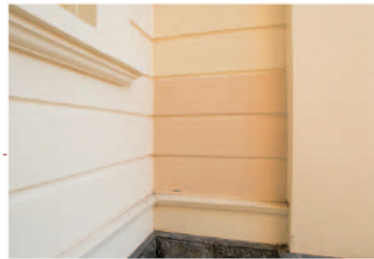
礼拝堂の正面外壁。色違いの部分は旧塗膜。下見板の間をふさぐシーリング材は塗料と色を合わせ、塗り替え後に施工し直した
