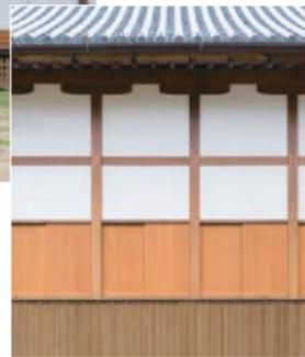
建物南面の一部。建具は新しいものに取り替えた。塗料は同じ「ビニー」を用いたものの腰板との間で仕上がりに差が見られるのは、そのため
