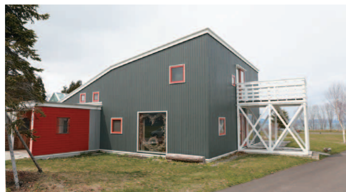
センターハウス。噴火湾パノラマパークの宿泊ゾーン「オートリゾート八雲」の管理棟にあたる。外壁はキシラデコールコンゾランの「シルバグレイ」で、建具はアクセントとして「レッド」を加えた
