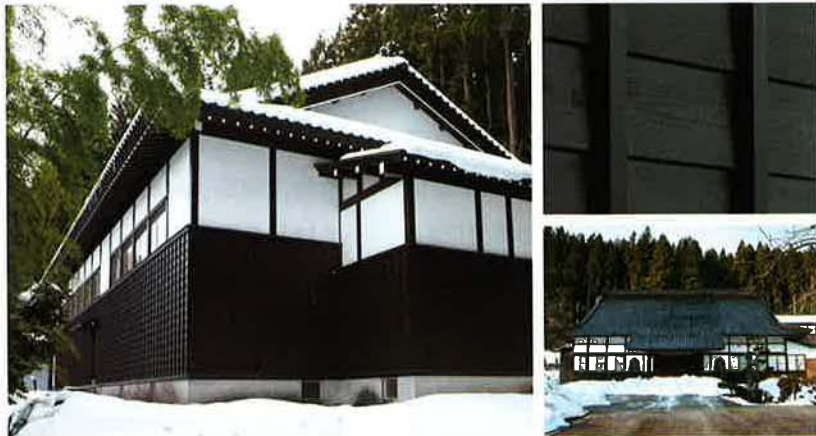
瑞光寺の位牌堂。外壁の下見板と軒裏の垂木を、南面と東面は2010年に、残る北面と西面は翌11年に塗り替えた。色は「ダークブラウン」。写真右上のように、木目を見せながらツヤのある色を付けることができる。写真右下は、本堂。「ダークブラウン」と「チョコレート」の2色で仕上げた
