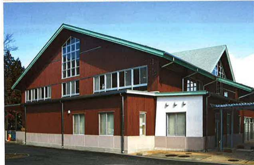
外壁塗り替えにあたって「キシラデコールフォレストエージ」を採用した体育館(写真下)。キシラデコールの性能はそのままに低臭性を実現した「フォレストエージ」は、溶剤の臭いへの配慮が必要な学校建築に適していると言える。写真右のように、体育館近くのプール管理棟も同じ「フォレストエージ」で塗り替えた
