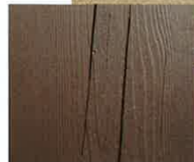
木製の桁橋である一の橋。補修工事ではその奥に見える二の橋とともに、木部に『キシラデコールコンゾラン』の前身である高耐久性塗料『コンゾラン』のチョコレート色を塗った。木部のひび割れには、ノンブリードタイプのウレタンコーキングを充填している
