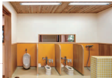
トイレも腰壁にスギ材を使用。ここではキシラデコールインテリアファイン「ワイス」で心材と辺材の色の差を和らげるように仕上げた
