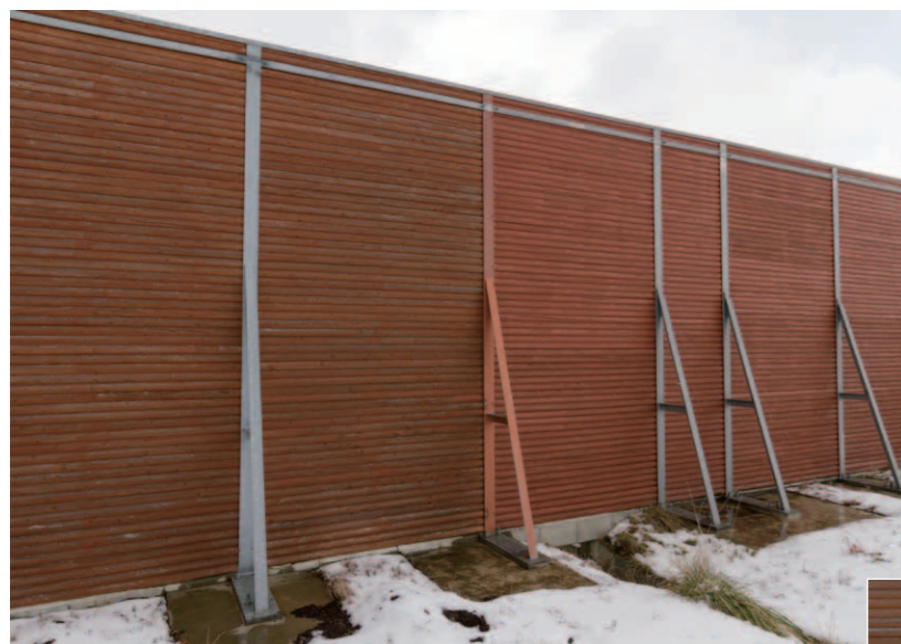
国産材合板工場である秋田プライウッド男鹿工場の敷地周りに、2010年10月に設置された防音壁。高さ3.7m、長さ500m近く。材料には、合板の製造工程で最後に残る「むき芯材」を用いている
