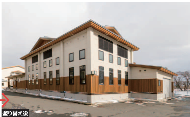
能代市立東雲中学校の体育館。外壁や軒天、建具に秋田県産のスギを使っている。2017年9月から10月にかけて外装メンテナンスを実施。木部の塗り替えには、キシラデコールフォレストエージのビニーを採用した
