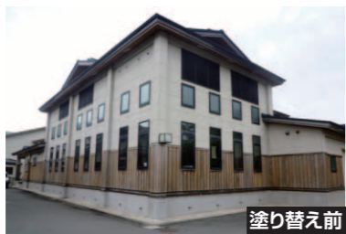
能代市立東雲中学校の体育館。外壁や軒天、建具に秋田県産のスギを使っている。2017年9月から10月にかけて外装メンテナンスを実施。木部の塗り替えには、キシラデコールフォレストエージのビニーを採用した
