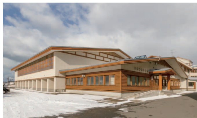
能代市立東雲中学校の体育館。外壁や軒天、建具に秋田県産のスギを使っている。2017年9月から10月にかけて外装メンテナンスを実施。木部の塗り替えには、キシラデコールフォレストエージのビニーを採用した
