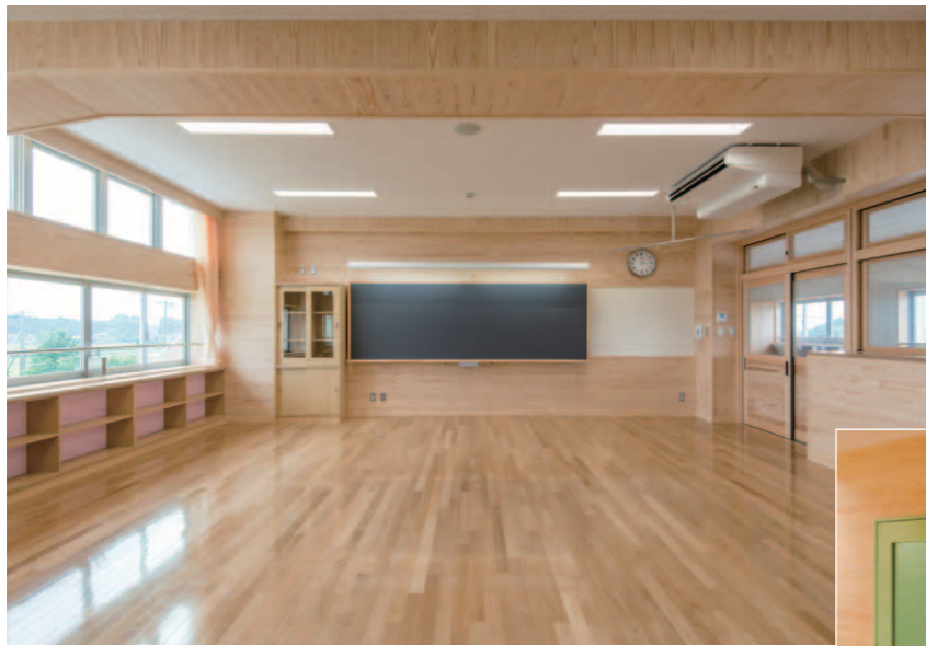
教室は柱や梁などをスギで覆い、屋内木部用美装・保護剤「キシラデコールインテリアファイントップコート 半ツヤ」で仕上げた。左手の欄間下には庇。その反射で光を教室の奥に引き込む
