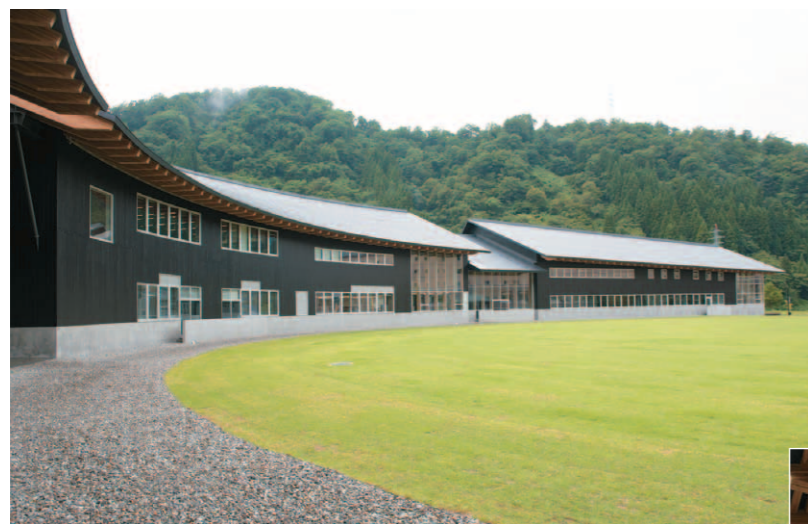
霊峰白山麓の豊かな自然を背景に、円形広場に面して弧を描くように広がる国際高等専門学校校舎。外壁は天然木縦張りに屋外木部用高性能木材保護塗料「キシラデコールコンゾラン」を塗装。垂木が連なる3mの大きな庇は外壁を雪から守る
