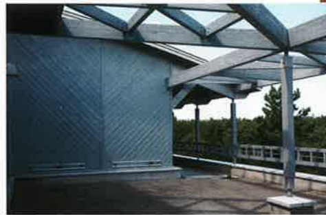
研究所本館の東面に当たる正面玄関。この面は、外壁、柱梁、軒天、建具と、木部すべてを塗り替えた
