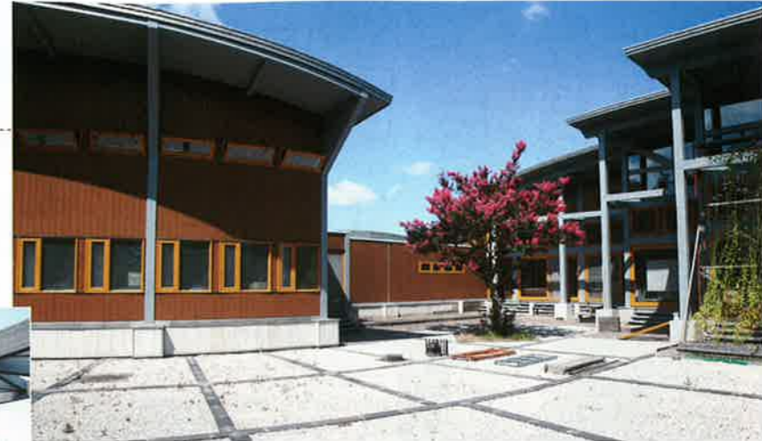
木材高度加工研究所本館南側。シンボルツリーを境に、右は柱梁や軒天などを、左は外壁や軒天などを、それぞれ「キシラデコールコンゾラン」で塗り替えた
