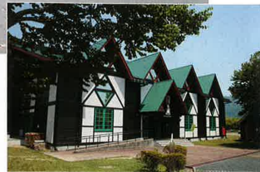
作業室を備えた「クラフト館」。ハーフトンバー様式を採用していたが、改修工事で外壁面の下半分は大壁に改め、外壁面を「キシラデコールコンゾラン」の「ジェットブラック」で仕上げた。写真右下は、研修室や展示室などを備えた「木の館」。黒く見える外壁面は、やはり「キシラデコールコンゾラン」で仕上げた。これらを含めて屋外木部にはすべて、「キシラデコールコンゾラン」を使用する
