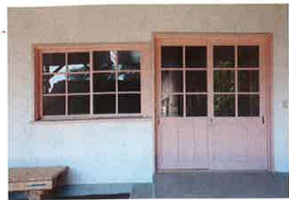
5棟の木造校舎を南北に結ぶ渡り廊下に面した建具も、校舎外装と同じく、「キシラデコールコンゾラン」を用いて建設当時と同じ肌色で塗り替えた
