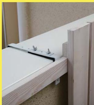
フェンス用固定金具 壁面のスノコを手すり本体にしっかりと固定するため、フェンス用固定金具で手すりと同様に、横木にスノコを取り付けます。
