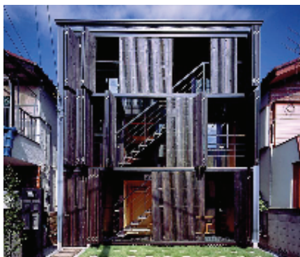
「千川・スクリーンの家」正面外観。スギ板にキシラデコールのジェットブラックを使い、耐久性を保たせつつインパクトあるファサードとした。
