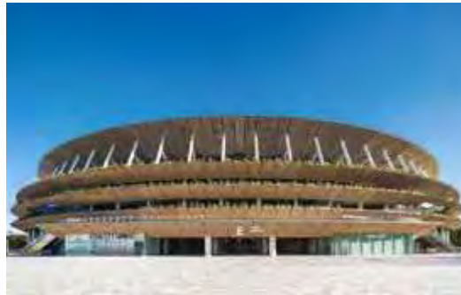
国立競技場(東京都) 写真提供:大成建設株式会社 ※業務用のキシラデコールシリーズの採用事例です。
