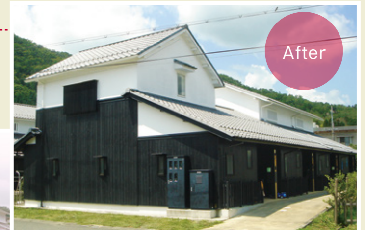
兵庫県篠山市 福住本陣団地(重要伝統的建造物群保存地区) キシラデコールアクオステージ#412ジェットブラック
