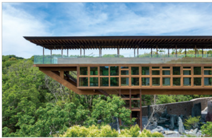
禅坊 靖寧 (兵庫県) キシラデコール やすらぎ+オリーブ使用
