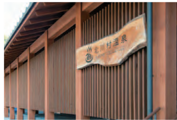
出入り口へのアプローチ沿いの格子。仕上げ塗料は、屋外木部用高性能木材保護塗料「キシラデコールフォレストージ」カスターニ
