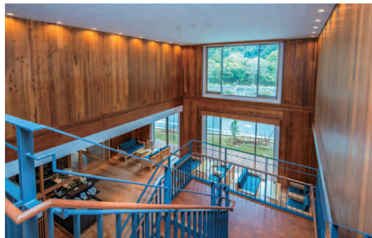
吹き抜けのロビーラウンジを見下ろす。CLT(直交集成板)の良さを生かそうと、3000×9705mmのパネルを、写真左手のようにウォールガーダー(壁梁)として用いる。壁柱と組み合わせた門型フレームで全体を支える造り
