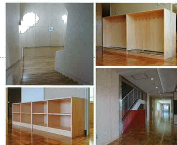
写真左上は階段室。こども教室と同じく、壁をシナベニヤで仕上げる。写真右上と左下は教室に設置された家具。これらも、シナベニヤ製。工場で製作し、現場で取り付け。写真右下は廊下。右手に並ぶ教室は廊下との間を一部だけ仕切ったオープンな造りなので、明るい。この壁面にもシナベニヤを用いる
