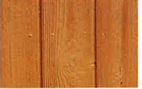
花巻市立成島保育園。昨年10月、木製の外壁と金属製の屋根を塗り替えた。外壁の塗り替えに用いたのは、キシラデコールコンゾランの「ビニー」。写真右上のように、木質感が損なわれないのが、特徴の一つだ
