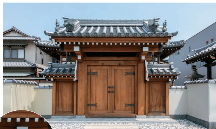
覚善寺の三門。今年5～6月、屋外木部用高性能木材保護塗料「キシラデコールフォレストエージ(ビニー仕上げ)」を塗装。小口部分には屋外木部用高耐久性木材保護塗料「キシラデコールコンゾラン(ワイス仕上げ)」を用いた(写真左)
