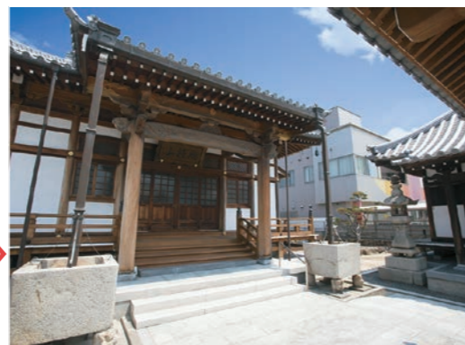
覚善寺の本堂。屋外に面した回廊と高欄に、今年5～6月、屋外木部用高性能木材保護塗料「キシラデコールフォレストエージ(ビニー仕上げ)」を塗装した。右手奥に一部見えている建物が、戦災で焼け残った阿彌陀堂
