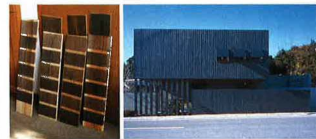
左 色の配合度合いを変えたキシラデコールを使用する材に実際に塗って、想定している色の配合度合いを確認する 右 設計を担当した「門前の家」。「シルバーグレイ」と「ジェットブラック」の2色を配合し、近くにある興国寺旧山門の色に見合う色を生み出した
